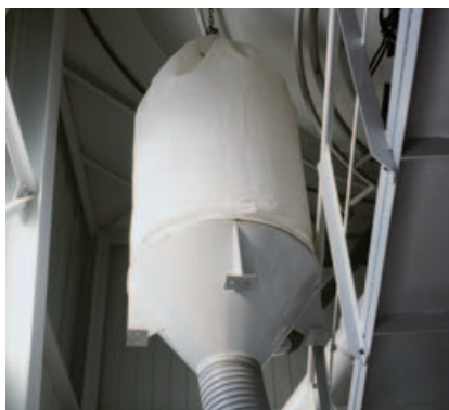
В качестве стандартного конструктивного исполнения пылеулавливание осуществляется посредством воздушного мешка. Он не пропускает воздух.
