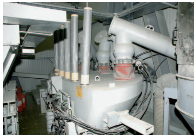
Весы для связующего оснащены динамометрическими датчиками. ■ Внутреннюю сторону весового резервуара защищает долговечное лаковое покрытие, облегчающее скольжение. ■ Стандартное конструктивное исполнение с шестью загрузочными отверстиями (по желанию до девяти) и вибратором. ■ При применении белого цемента используются вторые весы. ■ Устройство вытяжной вентиляции позволяет обеспечить оптимальную защиту от пыли. ■ Весы с двумя смесителями оснащены двухходовой системой распределения.
