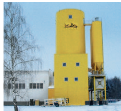
Теплоизоляция платформы смесителя и весов осуществляется с помощью многослойных панелей или панелей «профилированный лист/минеральная вата/гладкий лист». Также опционально можно облицовывать диапазон от \pm 0 до нижнего края платформы. Для теплоизоляции бункера с наполнителем используется профилированный лист/минеральная вата.
