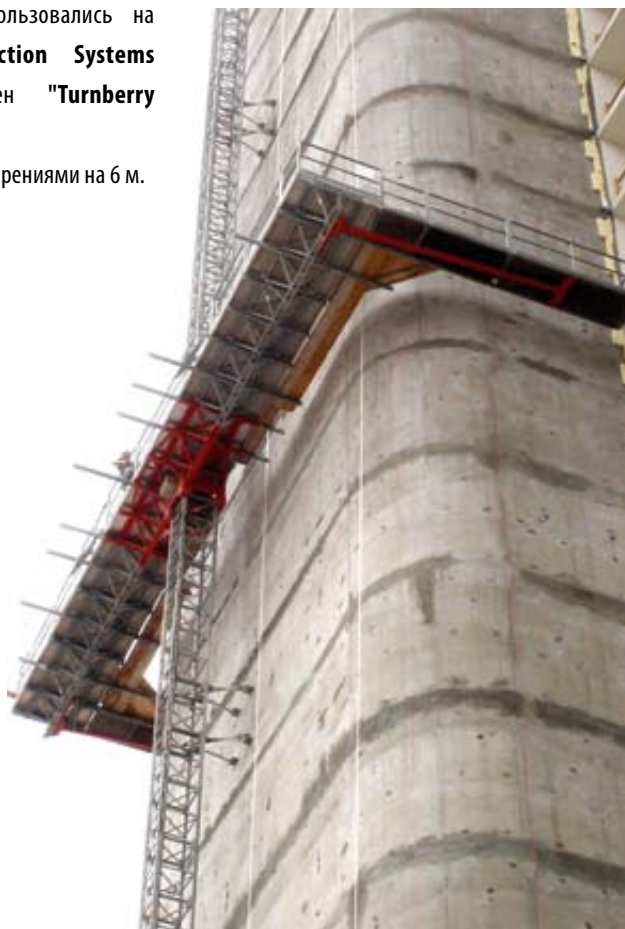
SCANCLIMBER SC5000 с расширениями на 6 м
