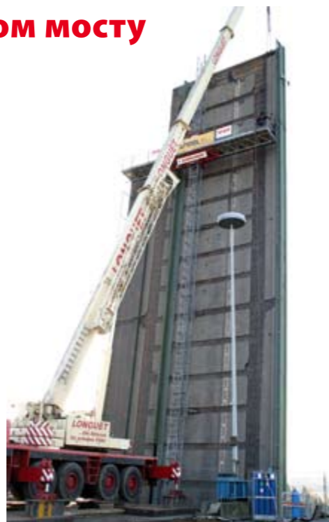
SC4000 установлен с углом наклона 7° для работы как одномачтовая транспортно-монтажная платформа
