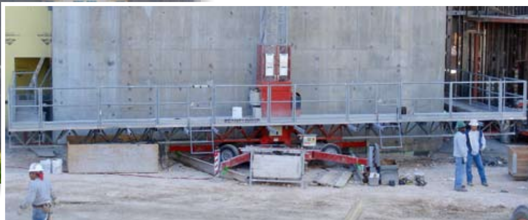
SCANCLIMBER SC5000 с расширениями на 6 м
